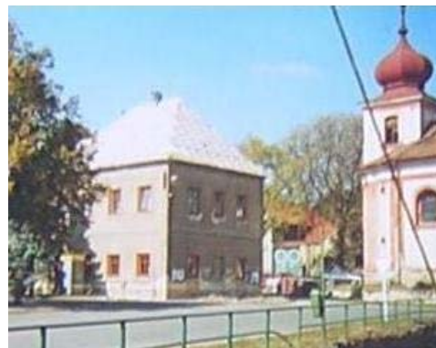
(čp. 80 - výměna oken a celková rekonstrukce střechy)
